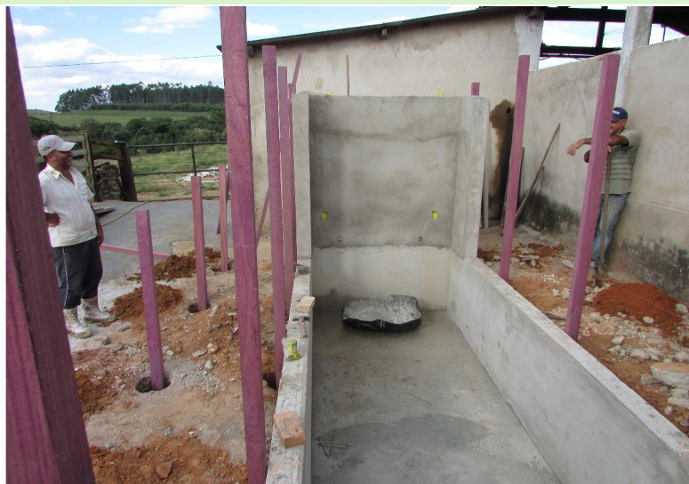
Construção de fosso de ordenha, Sítio Carandaí, Marcos Jaques.
